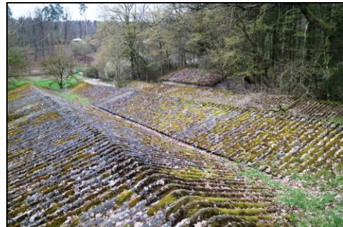
Dachflächen der Gebäude
