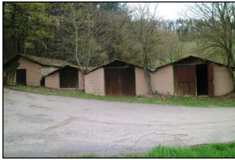
Vier längliche Gebäude der ehemaligen Pilzzucht
